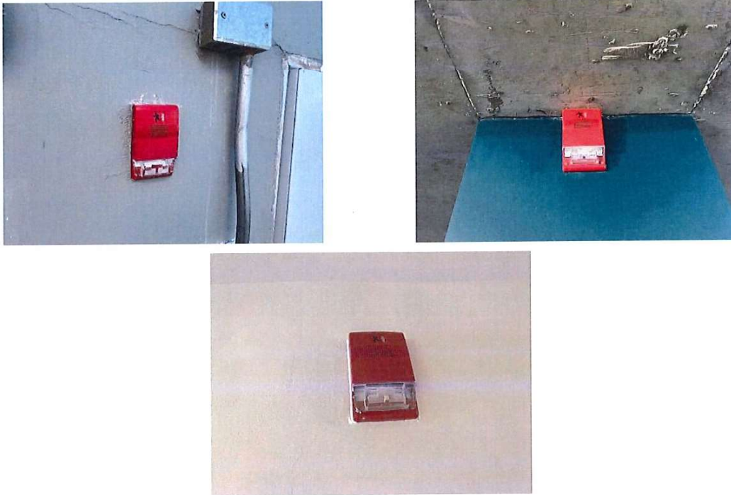
รูปที่ 47 เครื่องแจ้งเหตุด้วยแสง (Spraker With Strobe Light)
