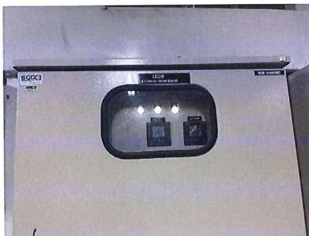
รูปที่ 58 มิเตอร์ไฟฟ้าระบบบำบัดน้ำเสีย
