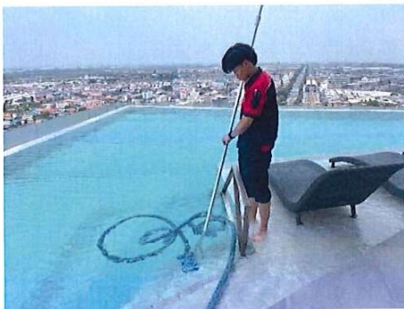
รูปที่ 60 ดูดตะกอนล้างตะไคร่ และตักเศษผงบริเวณสระว่ายน้ำ
