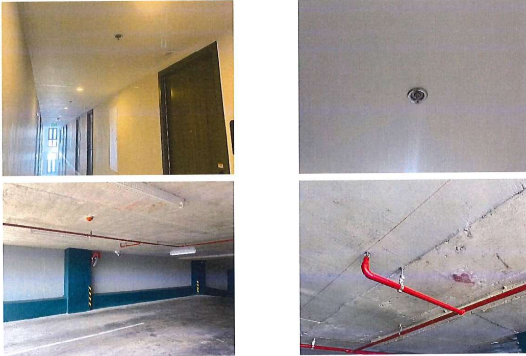
รูปที่ 40 ระบบหัวกระจายน้ำดับเพลิงอัตโนมัติ
