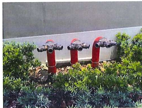
รูปที่ 37 หัวรับน้ำดับเพลิงภายนอกอาคาร (Fire Department Connector)
