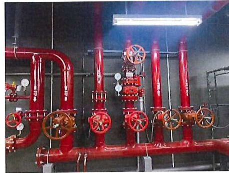
รูปที่ 36 ระบบท่อยืน (Stand Pipe)
