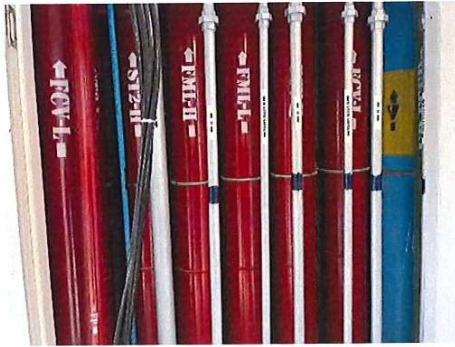
รูปที่ 36 ระบบท่อยืน (Stand Pipe)
