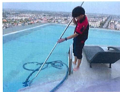
รูปที่ 60 ดูดตะกอนล้างตะไคร่ และตักเศษผงบริเวณสระว่ายน้ำ
