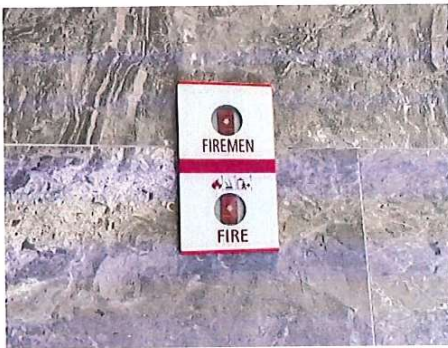
รูปที่ 45 เครื่องแจ้งเหตุโดยใช้มือดึง (Fire Alarm Manual Station)
