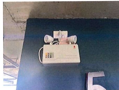
รูปที่ 33 ไฟฟ้าส่องสว่างฉุกเฉิน (Emergency Light)
