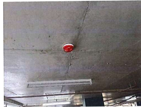
รูปที่ 43 เครื่องตรวจจับควัน (Smoke Detector)
