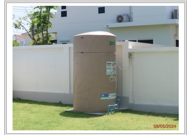
รูปที่ 3-12 ถังสำรองน้ำใช้ภายในบ้าน ขนาด 1.50 ลบ.ม.
