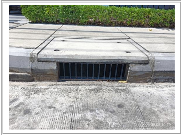
รูปที่ 3-30 ท่อระบายน้ำของโครงการ
