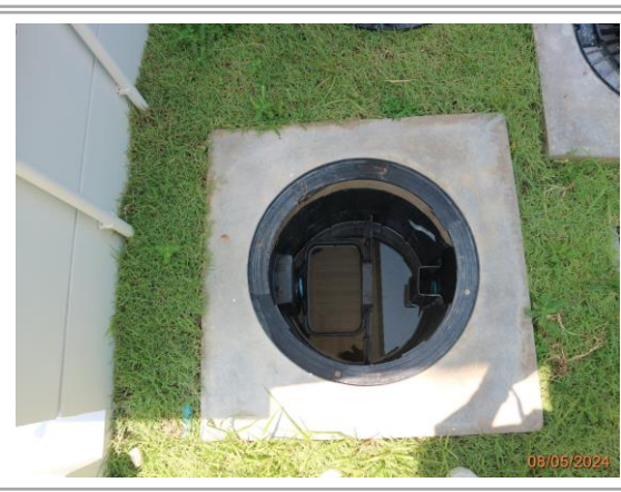
รูปที่ 3-13 ถังดักไขมัน และถังเก็บตะกอนภายในบ้านแต่ละหลัง
