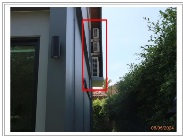
รูปที่ 3-7 การติดตั้งคอมเพรสเซอร์แอร์
