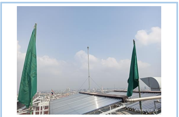
รูปที่ 3-38 ตัวนำล่อฟ้าของอาคาร
