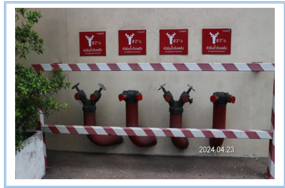
รูปที่ 3-61 ระบบหัวรับน้ำดับเพลิง
