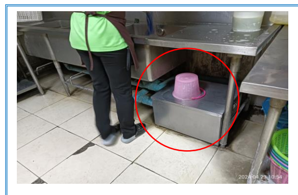
รูปที่ 3-12 ถังดักไขมันบริเวณห้องครัวของโรงแรม
