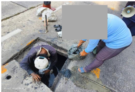
รูปที่ 3-15 การลอกท่อระบายน้ำของโครงการ
