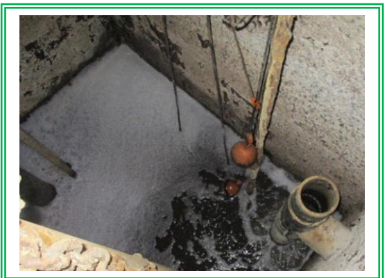
รูปที่ 3.2-6 บ่อรวบรวมน้ำเสียส่วนอาคารศูนย์การค้า และสำนักงาน
