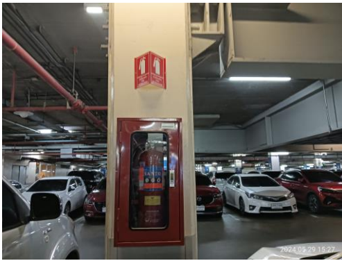
รูปที่ 3.2-31 เครื่องดับเพลิงชนิดมือถือ (Fire Extinguisher)
