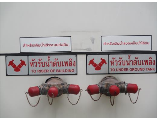
หัวรับน้ำดับเพลิง (Fire Department Connections)
