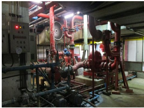
รูปที่ 3.2-29 ระบบท่อเย็นและระบบฉีดน้ำดับเพลิง
