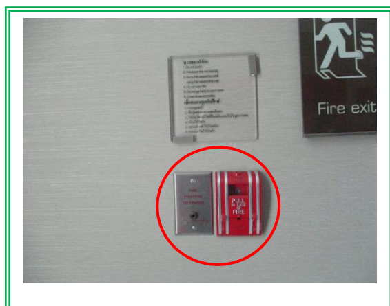
สวิตช์กดแจ้งเหตุด้วยมือ (Fire Alarm Manual Station)
