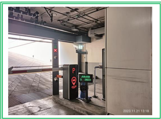
รูปที่ 3.2-2 เครื่องควบคุมสัญญาณไฟเตือนบริเวณลานจอดรถ
