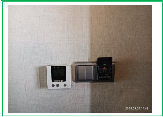
รูปที่ 3.2-49 ระบบ Key Tag ในห้องพัก ส่วนอาคารโรงแรม
