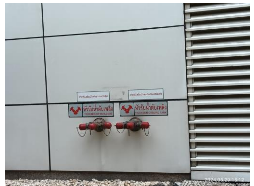
รูปที่ 3.2-33 หัวรับน้ำดับเพลิง (Fire Department Connections)
