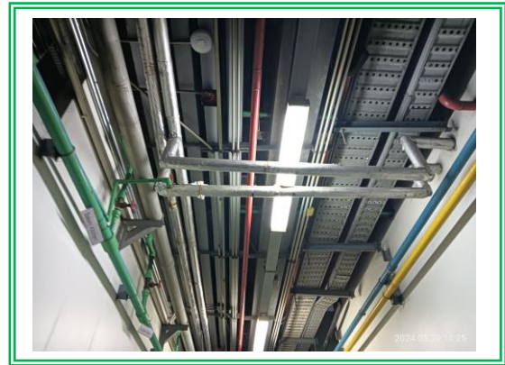
รูปที่ 3.2-8 การจัดระบบท่อประปาให้เป็นระเบียบ และแยกสีประเภทของน้ำ
