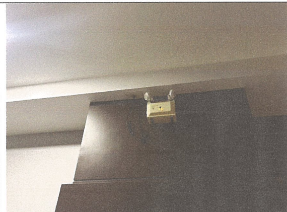
รูปที่ 2-12 ไฟฉุกเฉินภายในโครงการ
