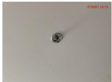
หัวฉีดน้ำ (Sprinkler)
