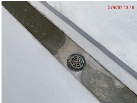
วางระบายน้ำและหัวรับน้ำฝน (RD) ชั้น ลาดฟ้า
