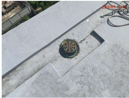
หัวรับน้ำฝน (Rain Drain)
