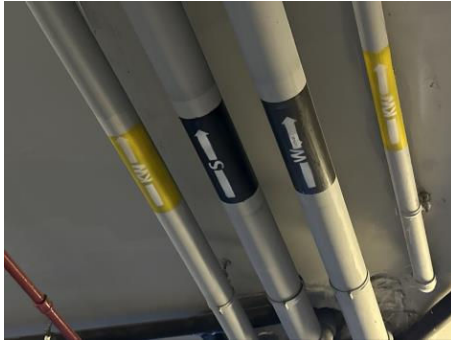
ท่อระบายน้ำเสีย (Waste Pipe, W) และ ท่อระบายสิ่งปฏิกูล (Soil Pipe, S)
