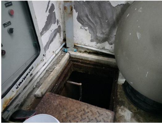
รูปที่ 31 บ่อพักน้ำใช้ใต้ดิน
