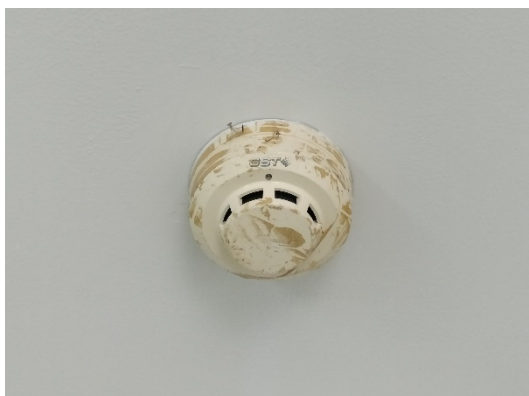
รูปที่ 29 ติดตั้งเครื่องตรวจจับควัน
