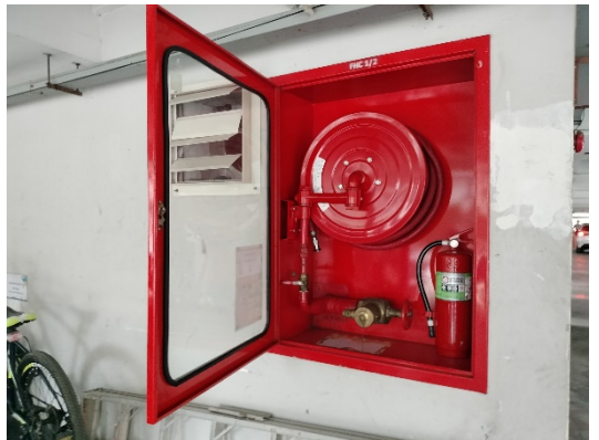
รูปที่ 18 สายฉีดน้ำดับเพลิงในตู้อาคาร
