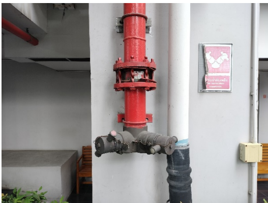
รูปที่ 9 หัวจ่ายน้ำดับเพลิงบริเวณข้างตัวอาคาร
