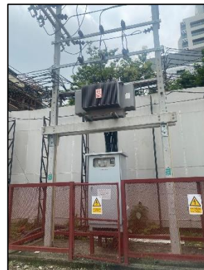
ภาพที่ 55 หม้อแปลงไฟฟ้า
