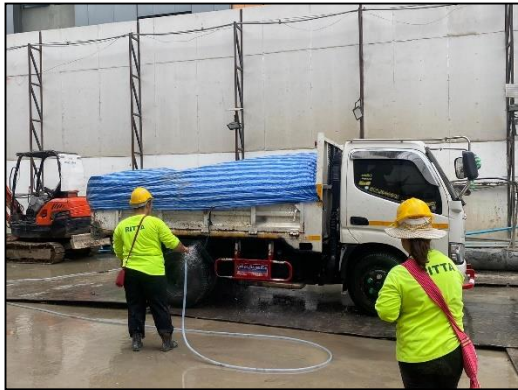
ภาพที่ 24 พื้นที่และกิจกรรมฉีดล้างล้อรถบรรทุก
