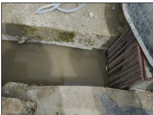
ภาพที่ 39 ตะแกรงดักขยะ
