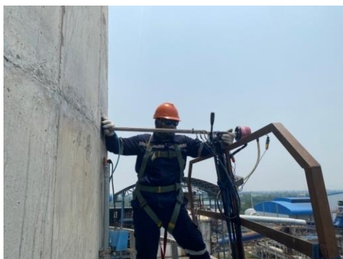
ภาพที่ 24 (ต่อ) การติดตั้งระบบติดตามตรวจสอบการระบายมลสารต่อเนื่อง (CEMs)
