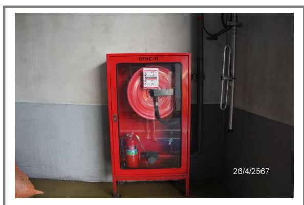
รูปที่ 3.1-49 ตู้เก็บสายฉีดน้ำดับเพลิง
