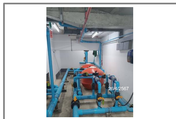
รูปที่ 3.1-24 ระบบกรองของสระว่ายน้ำ
