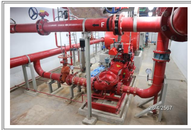
รูปที่ 2.5-6 เครื่องสูบน้ำดับเพลิง
