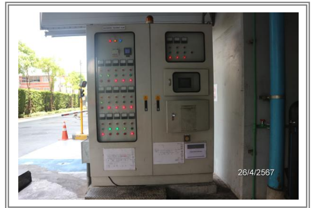
รูปที่ 2.5-2 ตู้ควบคุมระบบบำบัดน้ำเสีย
