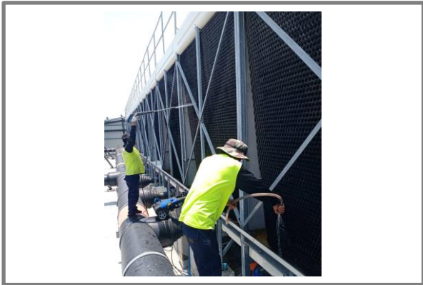
รูปที่ 3.1-73 กำจัดตะกอนในหอฝึ่งเย็น
