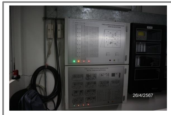
รูปที่ 3.1-53 แผงควบคุมระบบอัคคีภัย
