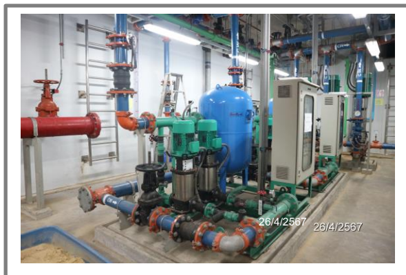
รูปที่ 3.1-20 ระบบสูบน้ำในอาคาร
