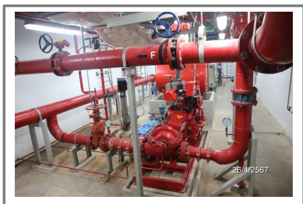
รูปที่ 3.1-47 เครื่องสูบน้ำดับเพลิง
