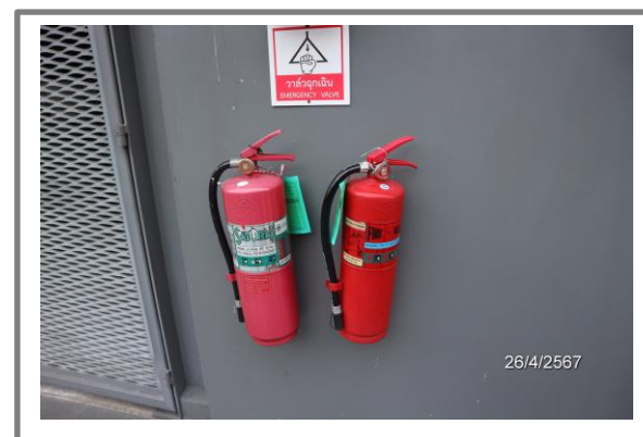
รูปที่ 3.1-50 ถังดับเพลิงแบบมือถือ
