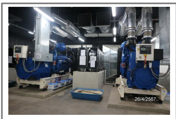
รูปที่ 3.1-41 ระบบไฟฟ้าฉุกเฉิน
