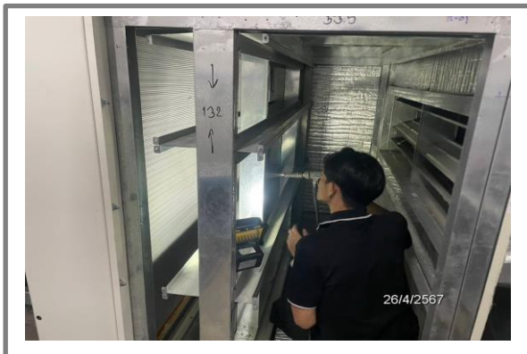
รูปที่ 3.1-74 ทำความสะอาดระบบปรับอากาศ
