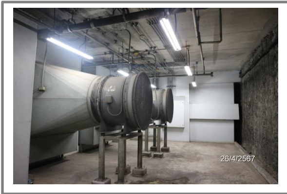
รูปที่ 3.1-7 เครื่องดูดและระบายอากาศบริเวณลานจอดรถ
