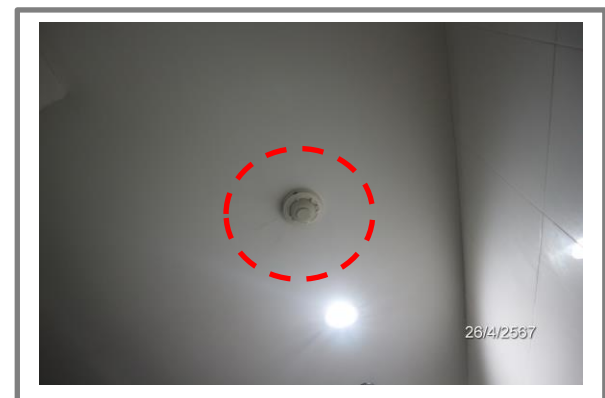
รูปที่ 3.1-54 เครื่องตรวจจับความร้อน
