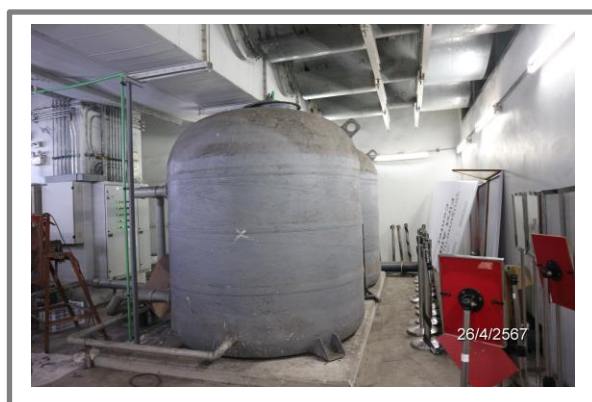
รูปที่ 3.1-15 ถังบำบัดก๊าซมีเทน
