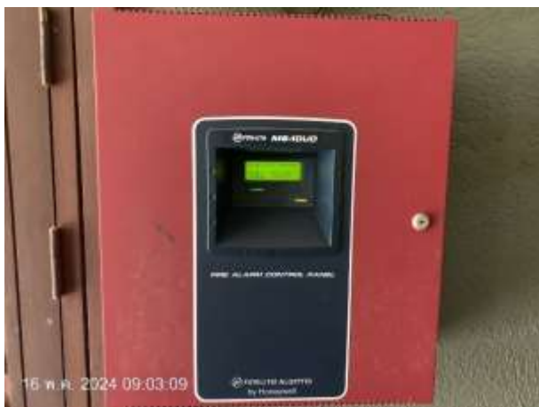
รูปที่ 27 แผงควบคุมสัญญาณเตือนไฟไหม้
