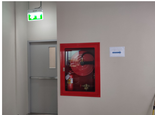
ภาพที่ 3-18 ท่อยืนและตู้เก็บสายฉีดน้ำดับเพลิงและอุปกรณ์
