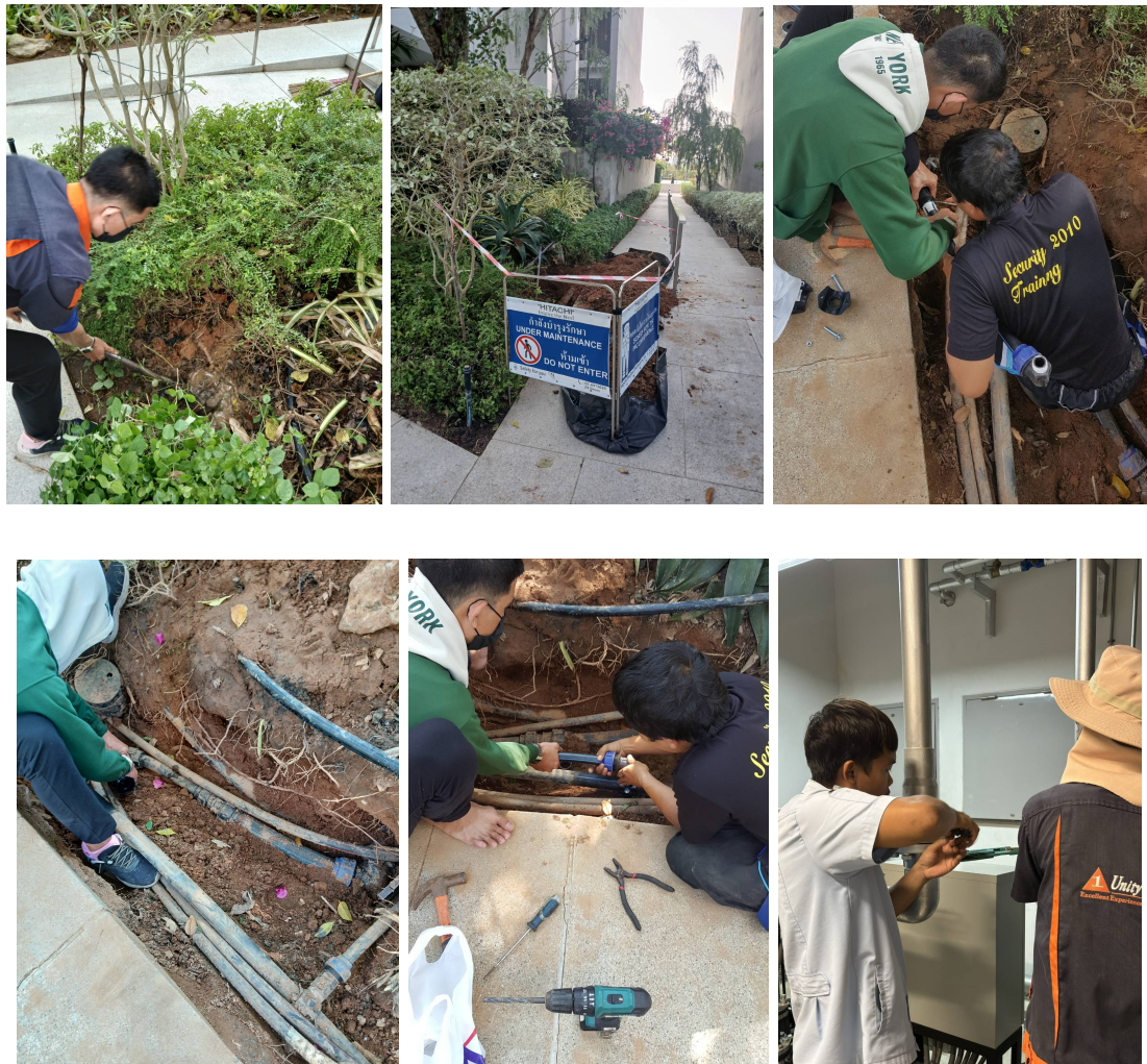
ภาพที่ 3-35 ตรวจสอบและซ่อมแซม ระบบท่อประปาภายในโครงการ
