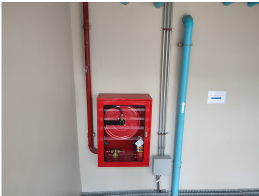
ภาพที่ 3-18 ท่อยืนและตู้เก็บสายฉีดน้ำดับเพลิงและอุปกรณ์
