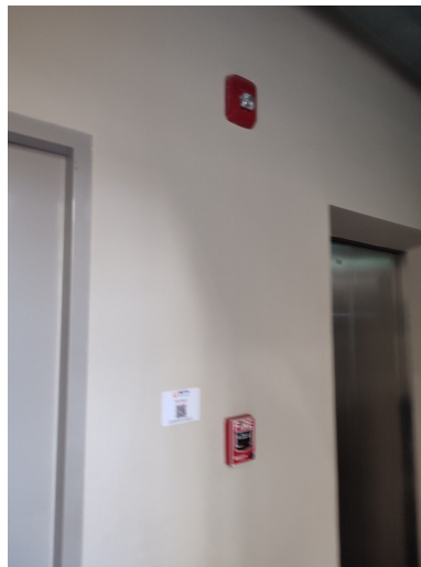
ภาพที่ 3-16 อุปกรณ์แจ้งเหตุอัคคีภัย และบันไดหนีไฟ
