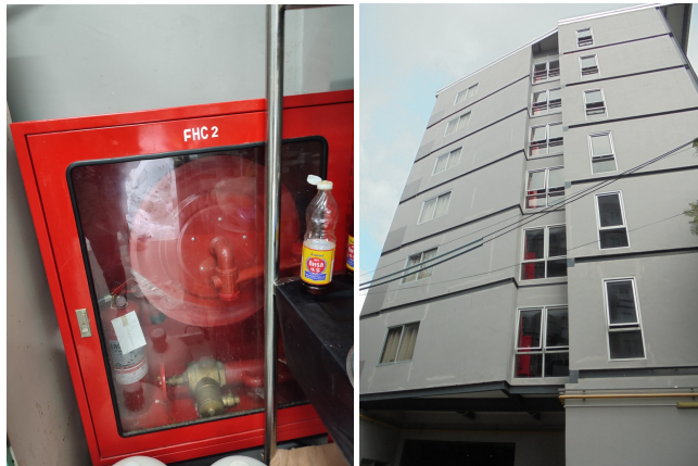
ภาพที่ 4-15 ระบบท่อเย็นและตู้เก็บสายฉีดน้ำดับเพลิงพร้อมอุปกรณ์
