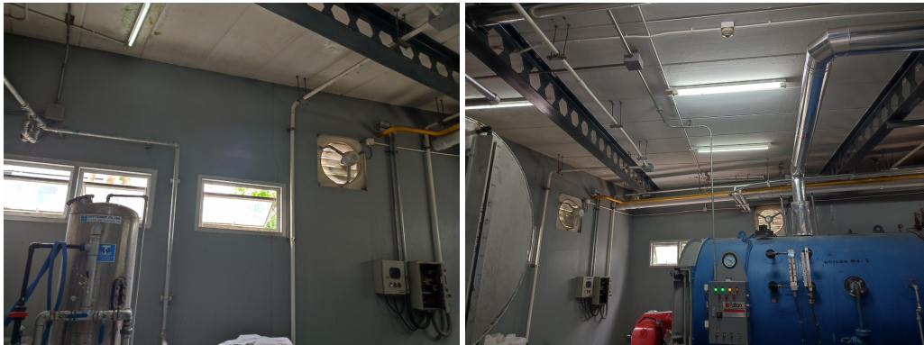
ภาพที่ 4-19 ช่องเปิดระบายอากาศของอาคาร และพัดลมระบายอากาศ และระบบเตือนอัคคีภัย
