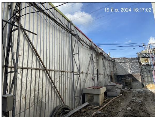
ภาพที่ 2 รั้ว Metal Sheet สูง 6 เมตร
