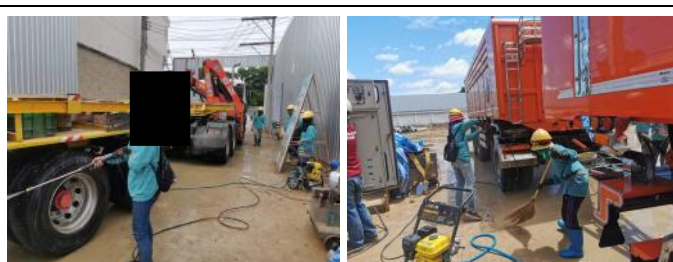
รูปที่ ๗7.20 การล้างล้อรถก่อนออกนอกพื้นที่โครงการ (ในช่วงก่อสร้าง)
