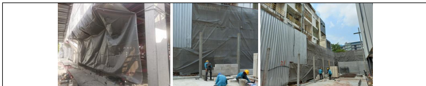
รูปที่ ผ7.11 ผ้าใบก่อสร้าง Mesh Sheet (ในช่วงก่อสร้าง)
