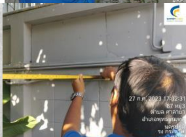
รูปที่ ๗7.21 การสำรวจ/ถ่ายภาพสภาพรั้ว กำแพงบ้าน และตัวอาคารก่อนก่อสร้าง (ในช่วงก่อสร้าง)
