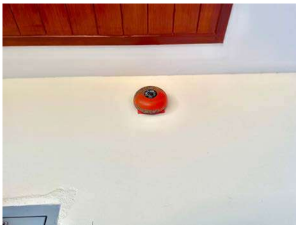
รูปที่ 1.11 กริ่งสัญญาณเตือนภัย (Alarm Bell)
