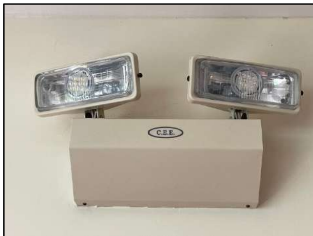
รูปที่ 1.9 ไฟส่องสว่างฉุกเฉิน
