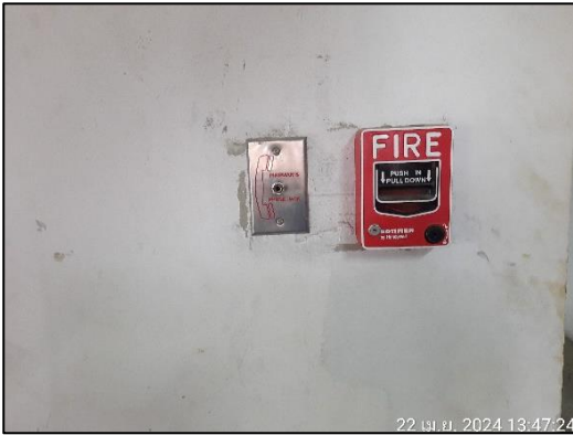
ภาพที่ 62 อุปกรณ์แจ้งเหตุเพลิงไหม้ด้วยมือ
