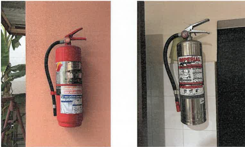
รูปที่ 3.2-35 ถังดับเพลิงเคมีชนิด ABC ขนาดความจุ 10 ปอนด์
