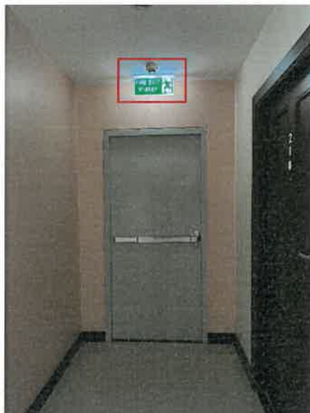
รูปที่ 3.2-39 ป้ายบอกทางหนีไฟ (Fire Exit Light)
