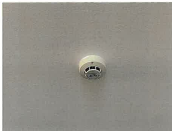
รูปที่ 3.2-36 เครื่องตรวจจับควัน (Smoke Detector)
