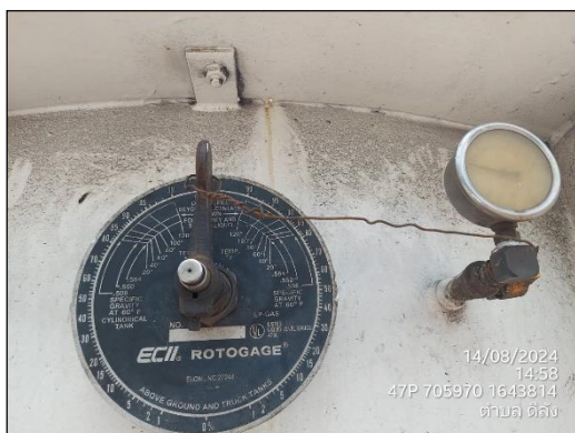
ภาพที่ 43 มาตรวัดแรงดันก๊าซ และอุปกรณ์ควบคุมความดัน
