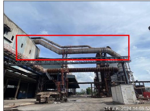
ภาพที่ 2 การติดตั้งระบบ Secondary Fume Exhausting
