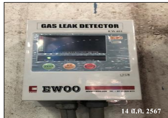
ภาพที่ 44 อุปกรณ์ตรวจวัดก๊าซรั่วไหล (Gas Detector)
