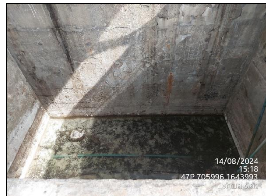
ภาพที่ 16 บ่อพักน้ำทิ้งขนาด 100 ลูกบาศก์เมตร
