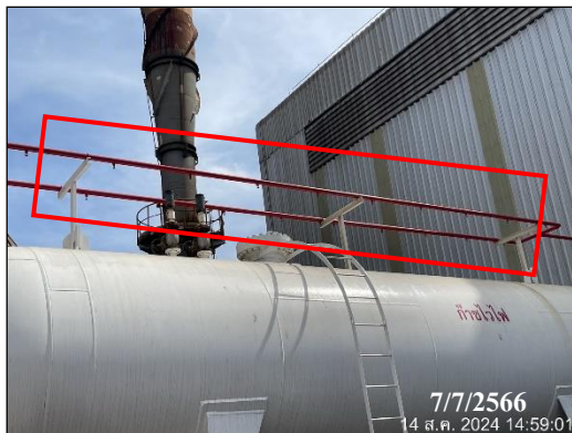
ภาพที่ 42 ระบบ Sprinkler เพื่อระบายความร้อน
