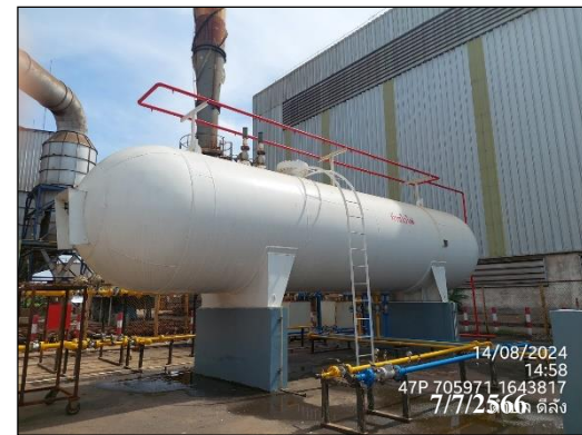
ภาพที่ 42 ระบบ Sprinkler เพื่อระบายความร้อน
