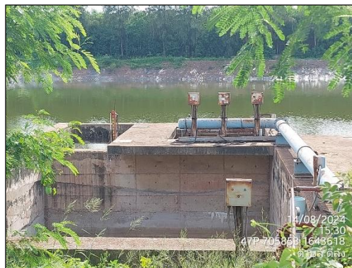
ภาพที่ 24 บ่อดักตะกอนชนิดบ่อกอนกริต ขนาด 900 ลูกบาศก์เมตร
