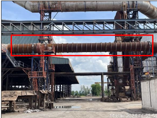
ภาพที่ 1 การติดตั้งระบบ Primary Fume Exhausting
