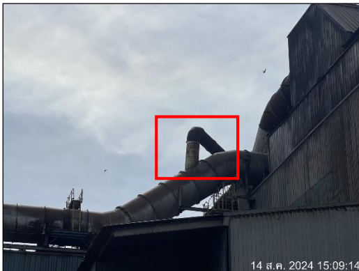
ภาพที่ 3 การติดตั้งระบบดูดฝุ่น Canopy Hood
