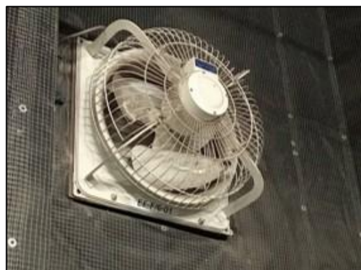
ภาพที่ 38 พัดลมระบายอากาศในห้องเครื่องกำเนิดไฟฟ้า
