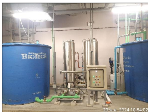
ภาพที่ 15 ถังสำรองน้ำขึ้นใต้ดิน
