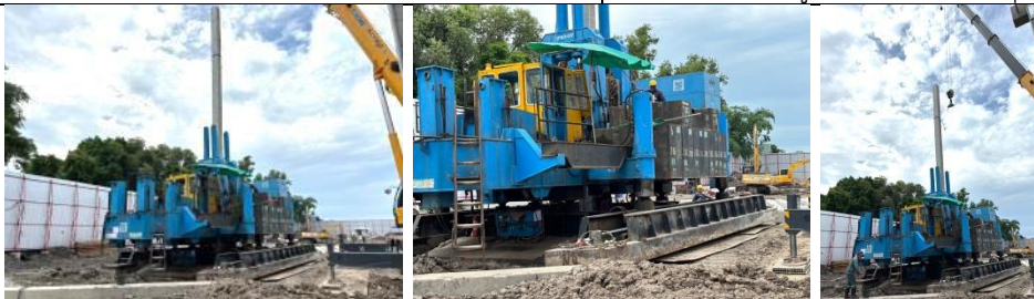
รูปที่ ๗7.19 ใช้เสาเข็มแบบกด (Jack In Pile)
