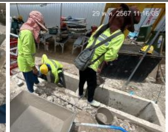
รูปที่ ๗7.33 เจ้าหน้าที่ชุดลอกตะกอนที่สะสมในบ่อดักขยะ
