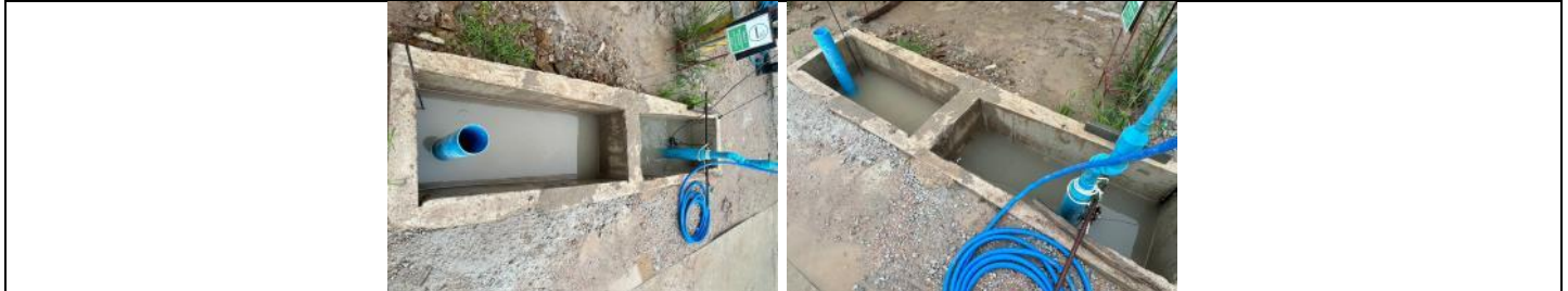
รูปที่ ๗7.24 บ่อดักขยะ เศษตะกอนดิน หิน กรวด ทราย
