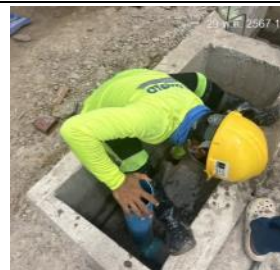
รูปที่ ๗7.33 เจ้าหน้าที่ชุดลอกตะกอนที่สะสมในบ่อดักขยะ
