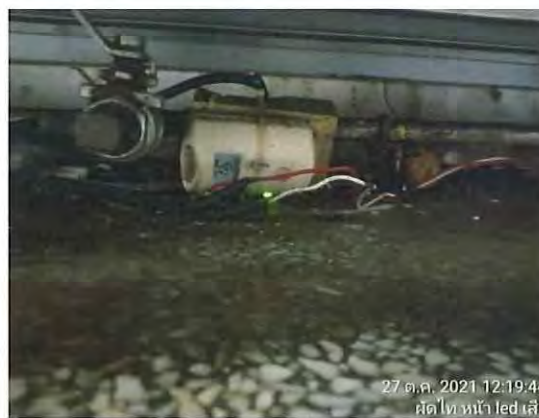
รูปที่ 3.9 ตรวจสอบพบว่าร้านผัดไท gas detector ไฟ Led เสีย
