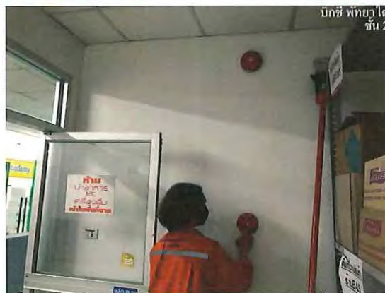
รูปที่ 2.15 ทดสอบ manual pull station
