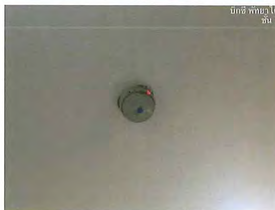
รูปที่ 2.18 ทดสอบ Heat detector พื้นที่ห้างสรรพสินค้า
