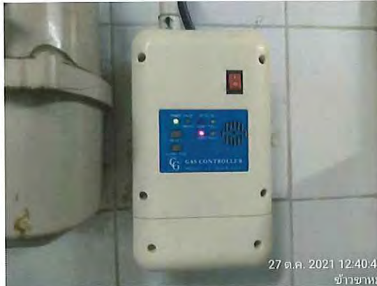
รูปที่ 2.50 ทดสอบ gas detector ,control panel,shut off valve ภายในร้านข้าวขาหมู
