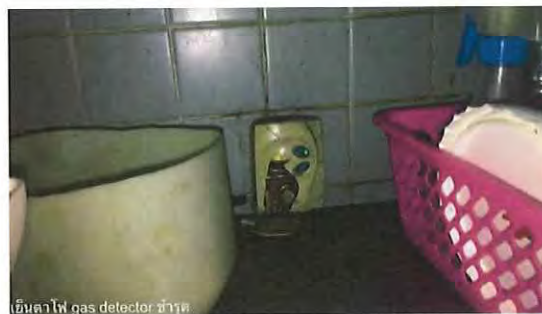
รูปที่ 2.44 ทดสอบ gas detector ภายในร้านยื่นเตาไฟ
