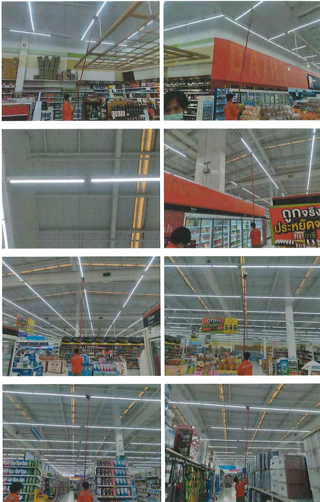
รูปที่ 2.11 ทดสอบ Smoke Detector ภายในห้างสรรพสินค้า
