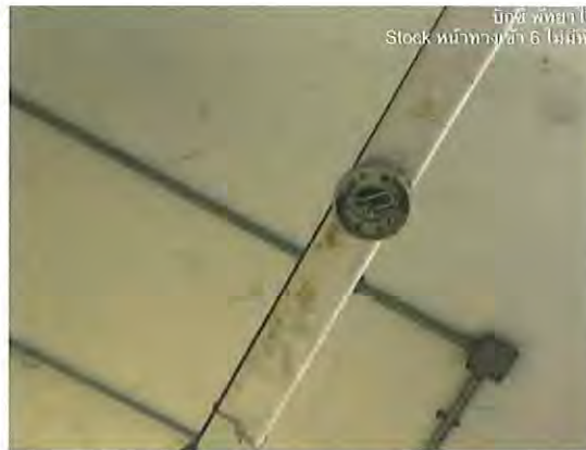
รูปที่ 3.2 ตรวจสอบพบว่าหน้าทางเข้า 6 Stock Smoke detector ไม่มีหัว Bypass
