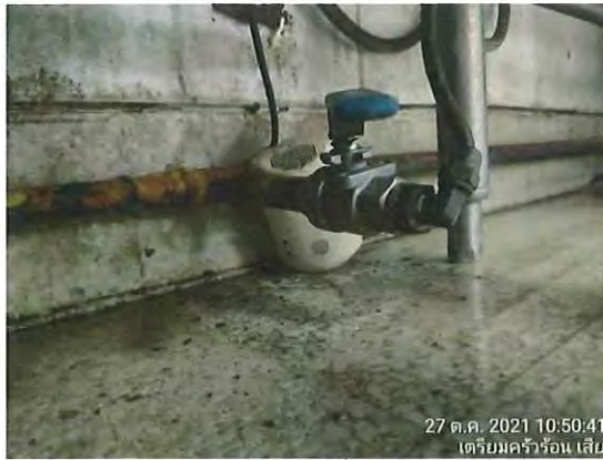
รูปที่ 2.37 ทดสอบ gas detector ภายในร้านครัวร้อนใน
