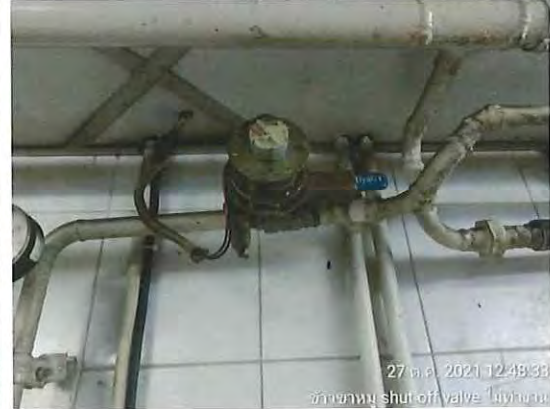
รูปที่ 2.50 ทดสอบ gas detector ,control panel,shut off valve ภายในร้านข้าวขาหมู
