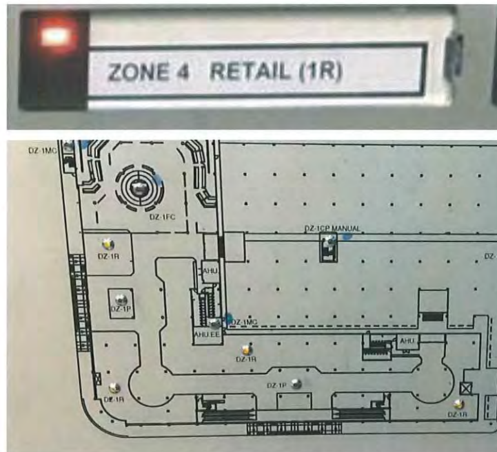
รูปที่ 2.26 ตู้ควบคุม และตู้กราฟฟิกแสดงผลแจ้งเหตุเพลิงไหม้ zone 04(DZ-1R)
