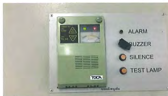
รูปที่ 2.55 ทดสอบ gas detector ภายใน gas station
