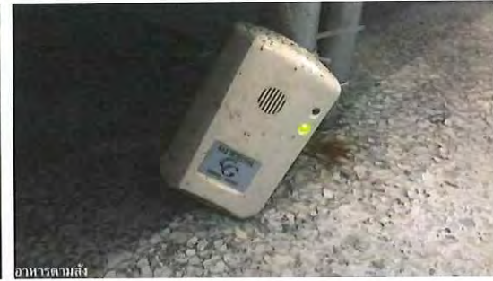
รูปที่ 2.50 ทดสอบ gas detector ,control panel,shut off valve ภายในร้านข้าวขาหมู
