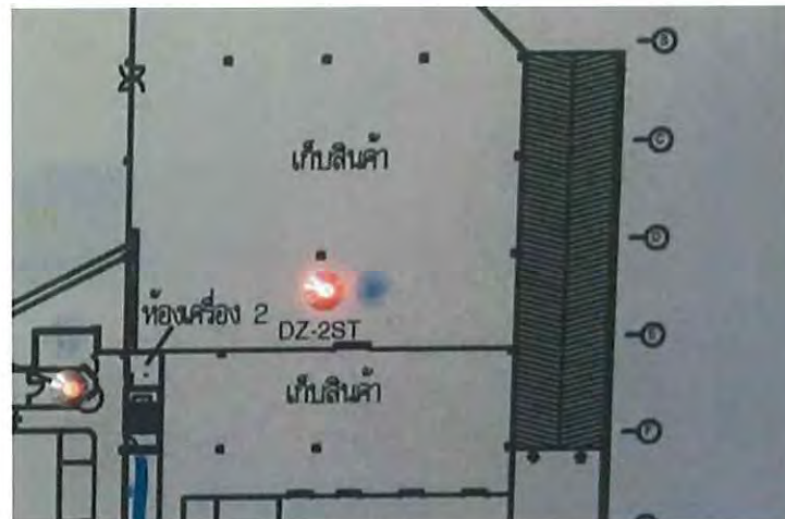
รูปที่ 2.34 ตู้ควบคุม และตู้กราฟฟิกแสดงผลแจ้งเหตุเพลิงไหม้ zone 14(STOCK&LOADING)
