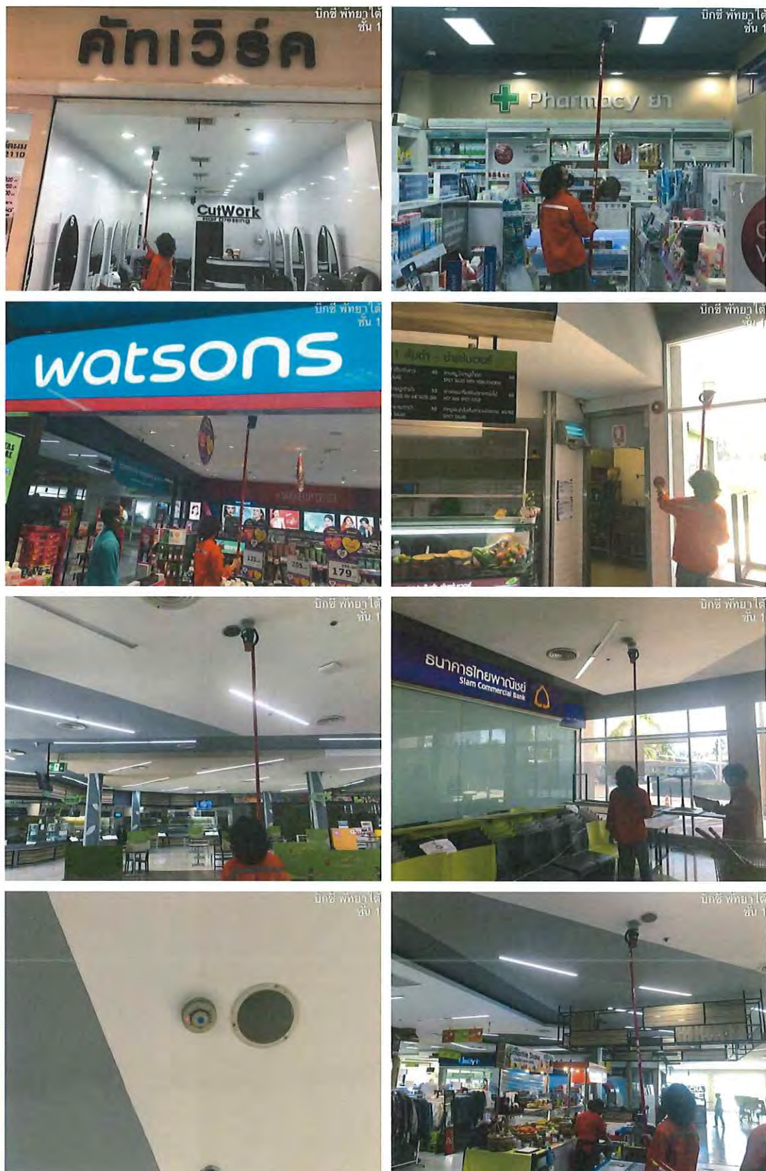
รูปที่ 2.20 ทดสอบ smoke detector พื้นที่ห้างสรรพสินค้า
