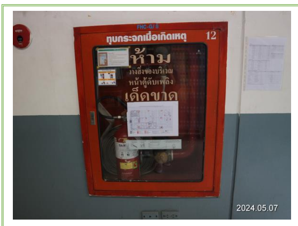
รูปที่ 3-22 ตู้สายฉีดน้ำดับเพลิง
