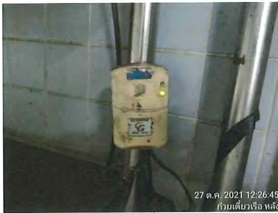
รูปที่ 2.43 ทดสอบ gas detector ภายในร้านท้ายเตาแก๊ส
