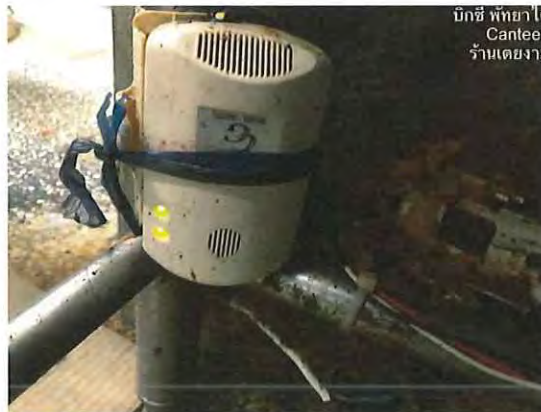
รูปที่ 2.39 ทดสอบ gas detector ภายในร้านหาดเตยงาม
