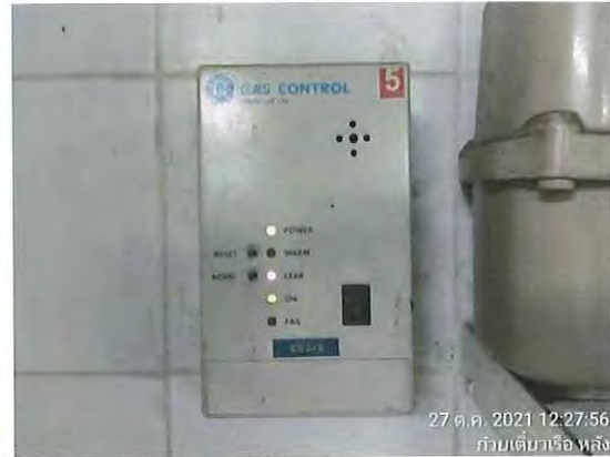
รูปที่ 2.43 ทดสอบ gas detector ภายในร้านท้ายเตาแก๊ส
