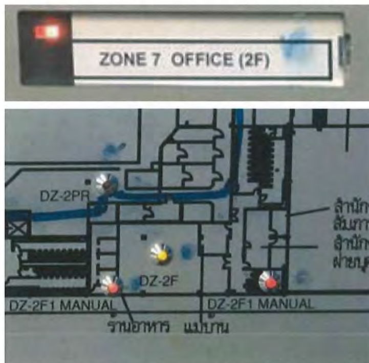
รูปที่ 2.27 ตู้ควบคุม และตู้กราฟฟิกแสดงผลแจ้งเหตุเพลิงไหม้ zone 07(DZ-2F)
