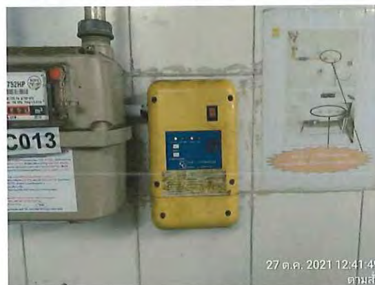
รูปที่ 2.51 ทดสอบ gas detector,control panel ภายในร้านอาหารตามสั่ง
