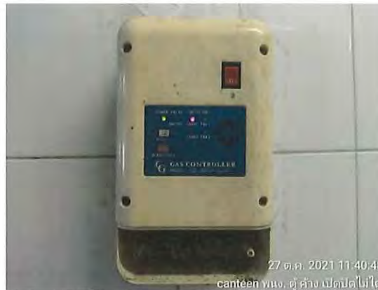
รูปที่ 3.8 ตรวจสอบพบว่าร้านเตรียมครัวร้อน gas detector เสีย
