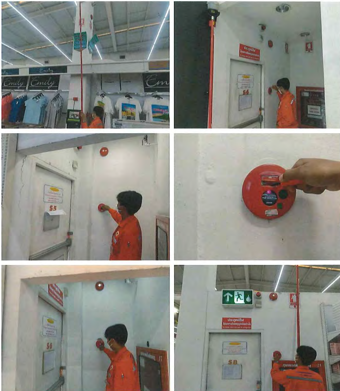
รูปที่ 2.13 ทดสอบ manual pull station ประตุนิไฟ และภายในห้างสรรพสินค้า
