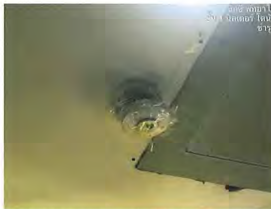
รูปที่ 3.3 ตรวจสอบพบว่าหน้าร้าน มิสเตอร์โดนัท Smoke detector ชำรุด
