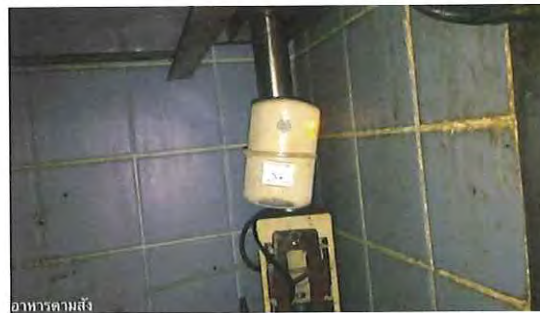
รูปที่ 2.50 ทดสอบ gas detector ,control panel,shut off valve ภายในร้านข้าวขาหมู
