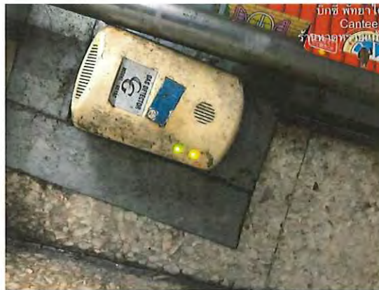
รูปที่ 2.38 ทดสอบ gas detector ภายในร้านหาดทรายแก้ว
