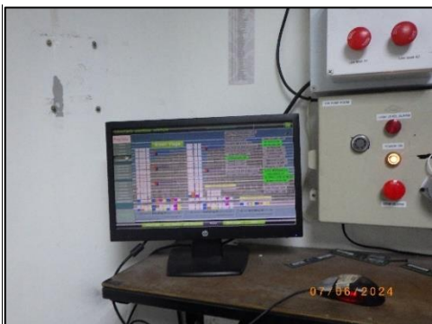
รูปที่ 2-29 อุปกรณ์เปิด-ปิดระบบแสงสว่างอัตโนมัติ
