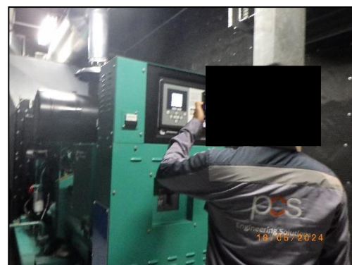
รูปที่ 2-48 เครื่องกำเนิดไฟฟ้า ขนาด 315 KVA จำนวน 1 ชุด สามารถสำรองไฟได้นาน 8 ชั่วโมง ในกรณีระบบไฟฟ้าขัดข้อง (1)
