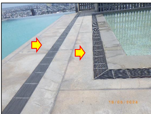
รูปที่ 2-29 รางระบายน้ำล้นมีฝาด้านบนสระว่ายน้ำ
