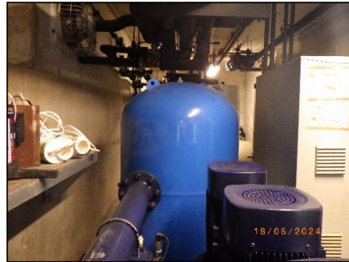
รูปที่ 2-20 ระบบสูบน้ำในอาคาร ซึ่งทำหน้าที่สูบน้ำ โดยไม่ดึงน้ำเข้ามาจากท่อประปาโดยตรง และควบคุมการจ่ายน้ำด้วยระบบตั้งเวลา
