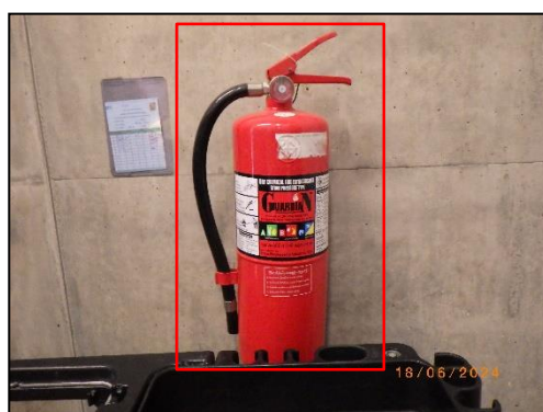
รูปที่ 2-72 ถังดับเพลิงเคมี (ABC Dry Chemical) แบบมือถือ บริเวณห้องเครื่องสูบน้ำดับเพลิงของอาคาร
