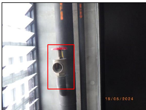
รูปที่ 2-65 ระบบท่อยืน (Stand Pipe)
