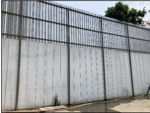
ภาพที่ 1 รั้ว Metal Sheet ความสูง 6 เมตร โคยรอบแนวเขตที่ดิน
