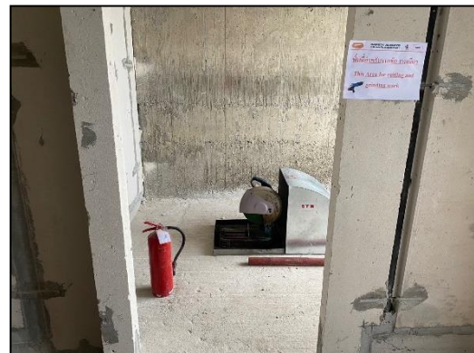
ภาพที่ 13 พื้นที่สำหรับตัด เจียร
