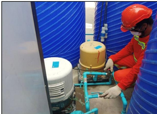
ภาพที่ 25 ตรวจสอบจุดรั่วซึมของเส้นท่อประปา
