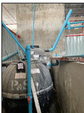
ภาพที่ 19 ระบบบำบัดน้ำเสียสำเร็จรูป
