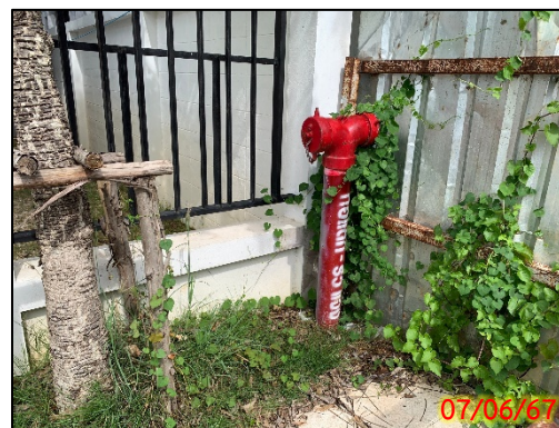
รูปที่ 2.2-6 หัวรับน้ำดับเพลิงภายในโครงการ
