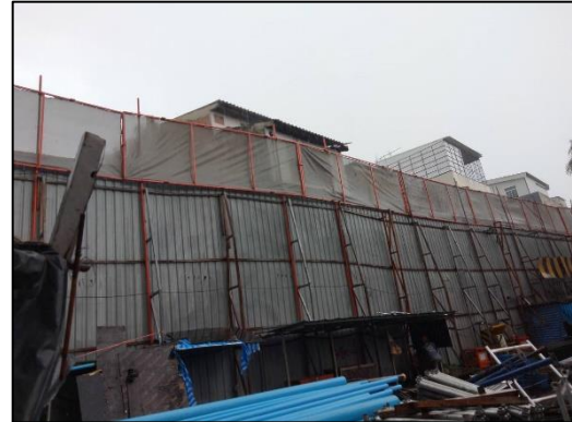
ภาพที่ 1 รั้ว Metal Sheet ความสูง 6 เมตร ต่อด้วย Mesh Sheet ความสูง 2 เมตร รอบพื้นที่โครงการ
