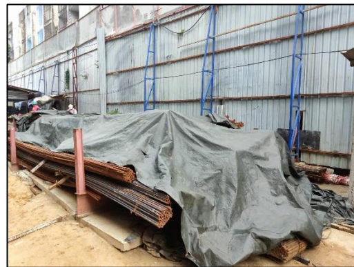
ภาพที่ 14 ผ้าใบปิดคลุมวัสดุก่อสร้าง
