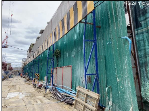
ภาพที่ 1 รั้ว Metal Sheet ความสูง 6 เมตร ต่อด้วย Mesh Sheet ความสูง 2 เมตร รอบพื้นที่โครงการ
