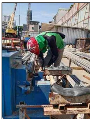
ภาพที่ 36 วัสดุกันกระแทกเพื่อลดเสียง
