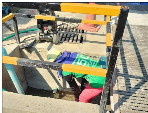
ภาพที่ 40 กิจกรรมขุดลอกท่อระบายน้ำในพื้นที่โครงการ
