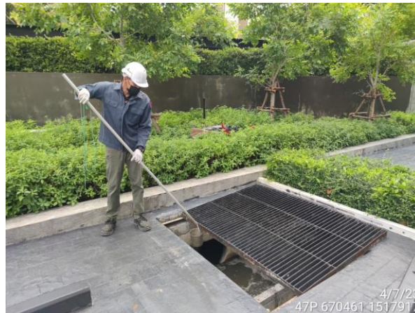
บ่อกักน้ำสุดท้ายของระบบระบายน้ำของโครงการก่อนระบายลงสู่ระบบท่อระบายน้ำสาธารณะ
