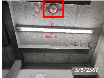
ระบบเปิด-ปิดไฟอัตโนมัติ
