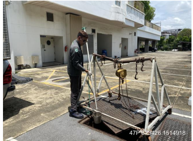
จุดระบายน้ำเสียจากระบบบำบัดทั้งที่ออกจาก ส่วนตกตะกอน ชุดที่ 1
