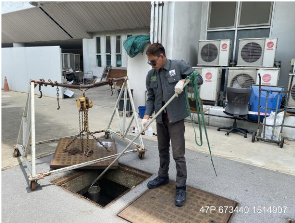
จุดระบายน้ำเสียจากระบบบำบัดทิ้งที่ออกจาก ส่วนตกตะกอน ชุดที่ 2
