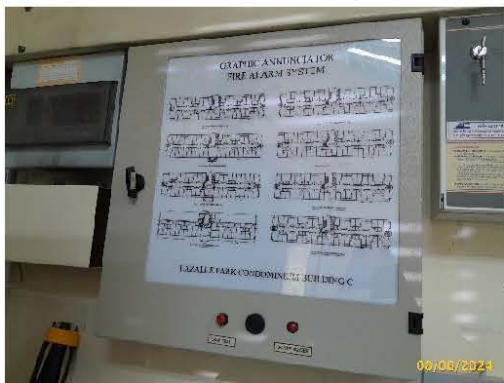
แผงควบคุมสัญญาณแจ้งเหตุเพลิงไหม้
