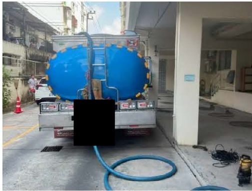
ภาพที่ 2.2-20 (ต่อ) การสูบน้ำจากระบบบำบัดน้ำเสีย
