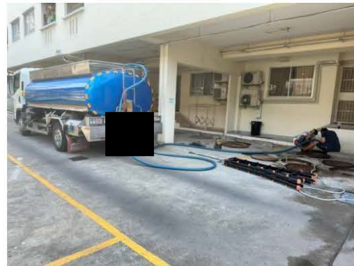
ภาพที่ 2.2-20 (ต่อ) การสูบน้ำจากระบบบำบัดน้ำเสีย
