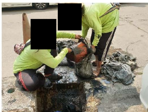
ภาพที่ 2.2-4 การขุดลอกระบบระบายน้ำ
