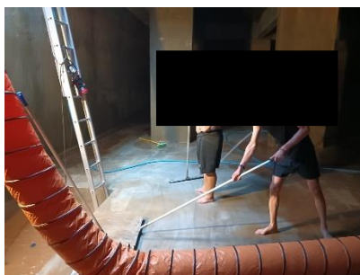
ภาพที่ 2.2-28 การล้างถังเก็บน้ำในโครงการ
