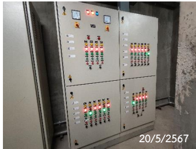
ตู้ควบคุมระบบบำบัดน้ำเสีย อาคารพักอาศัย
