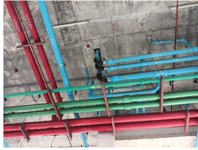
ภาพที่ 2.2-18 การตรวจสอบเส้นท่อประปา
