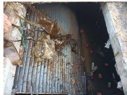
ภาพที่ 2.2-26 การตักใบไม้เศษขยะออกจากกระบบระบายน้ำ
