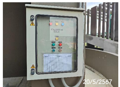
ตู้ควบคุมพัดลมระบายอากาศ
