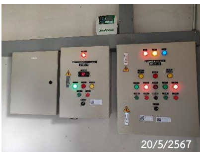
ตู้ควบคุมระบบบำบัดน้ำเสีย อาคารพาณิชย์
