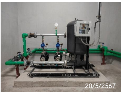
Booster Pump อาคารพักอาศัย
