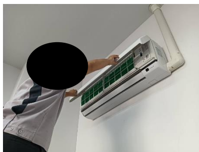
ภาพที่ 2.2-27 การล้างทำความสะอาดเครื่องปรับอากาศ
