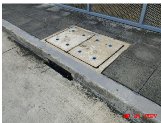
รูปที่ 9 ป่อท่วงน้ำและท่อระบายน้ำของโครงการ
