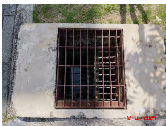
รูปที่ 9 ป่อท่วงน้ำและท่อระบายน้ำของโครงการ
