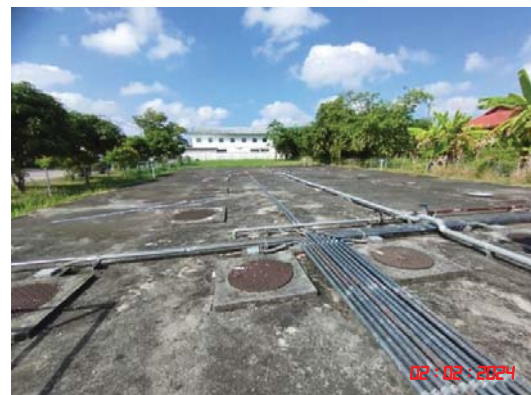
รูปที่ 3 ระบบบำบัดน้ำเสีย บ่อหน่วงน้ำ และป้ายเตือน
