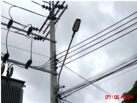
รูปที่ 11 ไฟฟ้าส่องสว่าง และหม้อแปลงไฟฟ้า
