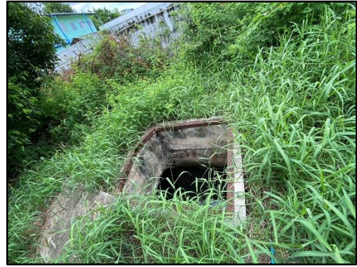
รูปที่ 12 ป่อพักน้ำก่อนปล่อยออกจากพื้นที่โครงการ
