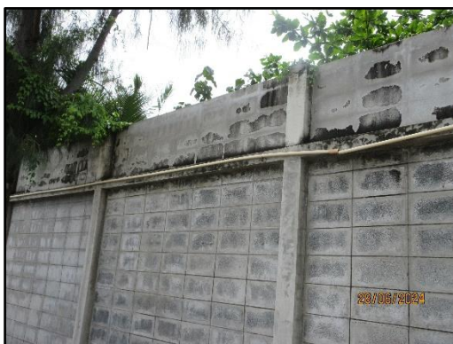
รูปที่ 2 กำแพงถาวรสูง 3 เมตร ที่มีวัสดุอุดฉาบเสียง ด้านติดกับโรงเรียนศิริวิทยา
