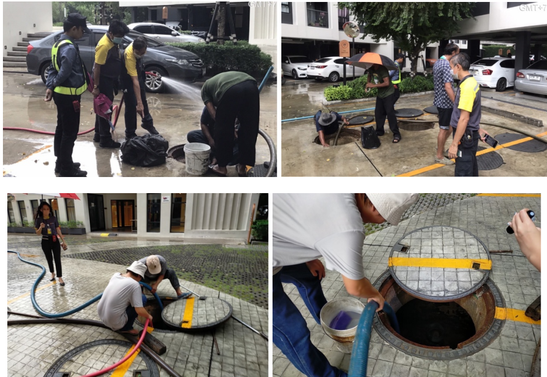
ภาพที่ 3-31 ซ่อมบำรุงระบบบำบัดน้ำเสีย สูบตะกอนไขมันและสูบตะกอนบ่อเกรอะ และระหว่างดำเนินการใช้กรวยกัน และดำเนินการในช่วงเวลากลางวัน
