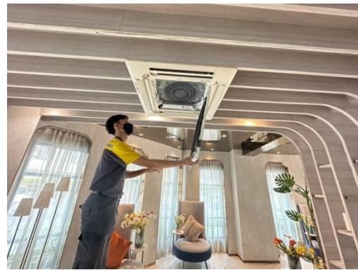
ภาพที่ 3-27 ล้างทำความสะอาดเครื่องปรับอากาศ
