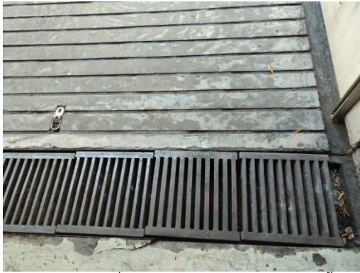
ภาพที่ 3-29 ตรวจสอบสภาพรางระบายน้ำมีสภาพดีไม่มีสิ่งอุดตันการระบายน้ำมีประสิทธิภาพ
