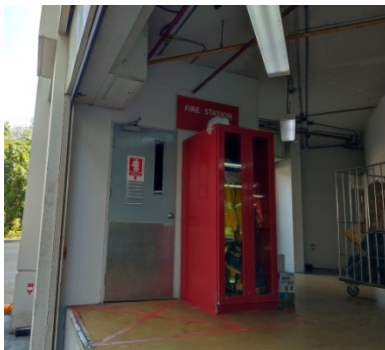
ตู้เก็บสายฉีดน้ำดับเพลิงพร้อมอุปกรณ์ ระบบท่อเย็น และสัญญาณแจ้งเตือนอัคคีภัย
