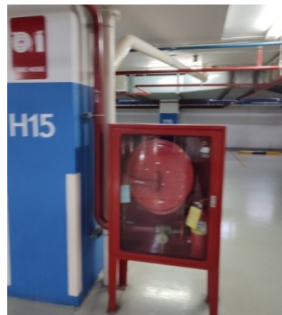
ตู้เก็บสายฉีดน้ำดับเพลิงพร้อมอุปกรณ์ ระบบท่อเย็น และสัญญาณแจ้งเตือนอัคคีภัย
