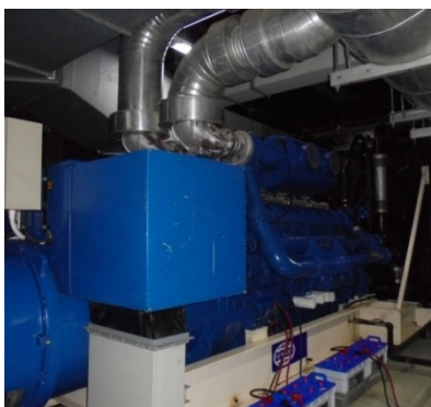
ที่ 3-26 ห้องเครื่องไฟฟ้าฉุกเฉินมีระบบขนวนป้องกันเสียงดัง ปล่องไอเสีย และเครื่องตรวจจับความร้อน
