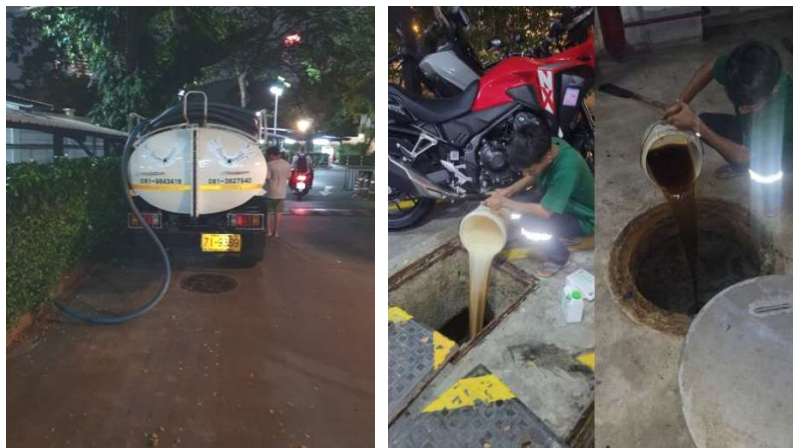
สูบล้างปลวกออกจากบ่อดักไขมัน และเติมสารชีวภาพในบ่อดักไขมัน ภาพที่ 3-27 ดูตะกอนไขมันและตะกอนในบ่อกักเก็บตะกอนของระบบบำบัดน้ำเสีย
