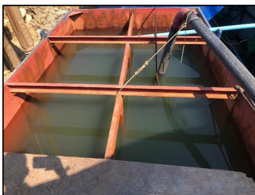
รูปที่ 1-6 ถังสำรองน้ำสำเร็จรูป บริเวณพื้นที่ก่อสร้างโครงการ
