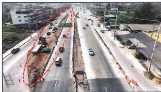
ภาพที่ 2 รางระบายน้ำลาดคอนกรีต บริเวณ กม.99+825 ถึง กม.100+120
