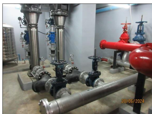
รูปที่ 9 ถังสำรองน้ำใช้ ฝาลัง วาล์วเปิดน้ำประปา สภาพน้ำในถัง และปั๊มสูบน้ำดับเพลิง
