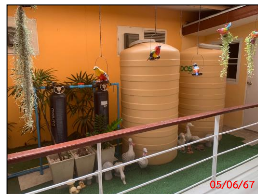
รูปที่ 2.2-10 ถังสำรองน้ำใช้ภายในโครงการ
