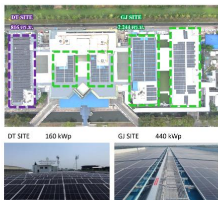
รูปที่ 2-35 การติดตั้งโซลาร์เซลล์บนชั้นดาดฟ้า
