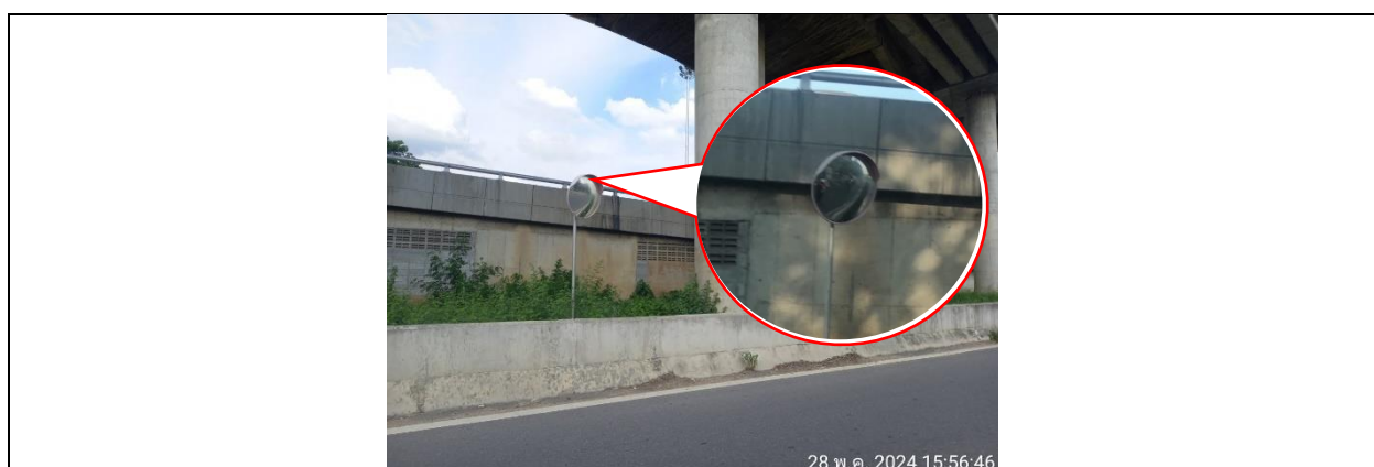
รูปที่ 2-20 การติดตั้งกระจกนูนบริเวณมุมอับทางถนนพุทธมณฑลสาย 4
