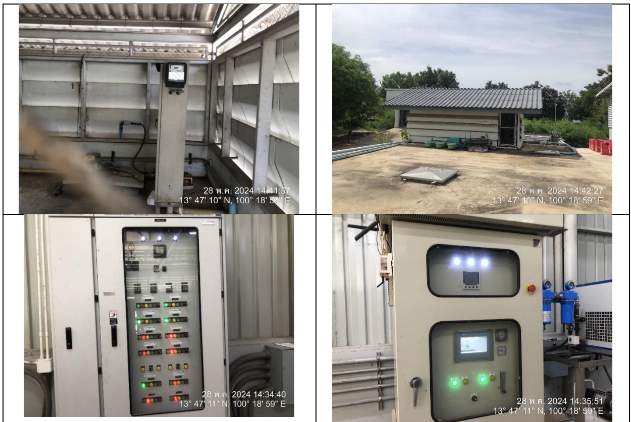
รูปที่ 2-12 การติดตั้งมิเตอร์ไฟฟ้าของระบบบำบัดน้ำเสียและการควบคุมการทำงานของระบบบำบัดน้ำเสีย
