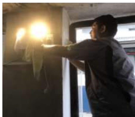
รูปที่ 3-8 การตรวจสอบสภาพความพร้อมใช้ของระบบไฟฉุกเฉินในโรงพยาบาล
