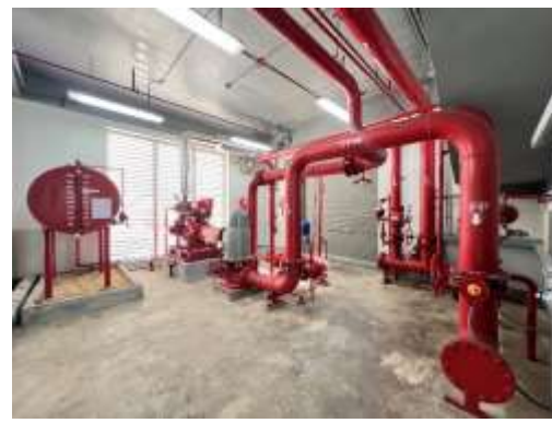
รูปที่ 2-23 บ่อสำรองน้ำ และปั้มน้ำดับเพลิง
