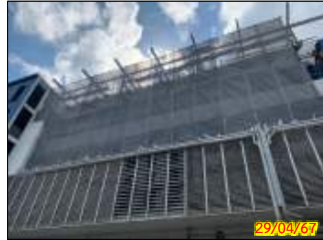
รูปที่ 2.2-2 ผ้าใบคลุมกันฝุ่นรอบอาคาร
