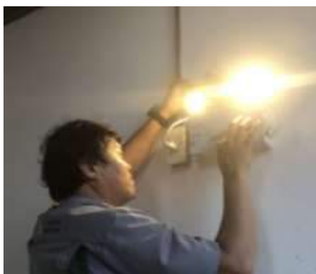
รูปที่ 3-8 การตรวจสอบสภาพความพร้อมใช้ของระบบไฟฉุกเฉินในโรงพยาบาล
