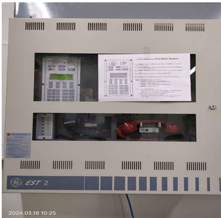
ภาพที่ 35 ระบบ Fire Alarm System ของโครงการ
