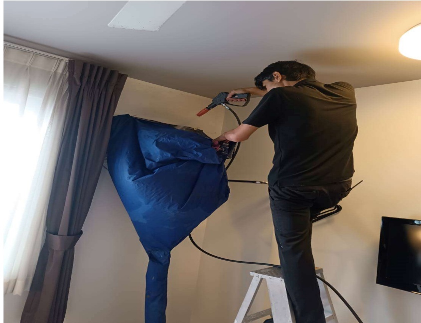
ภาพที่ 31 เจ้าหน้าที่ทำการล้างเครื่องปรับอากาศภายในโครงการ
