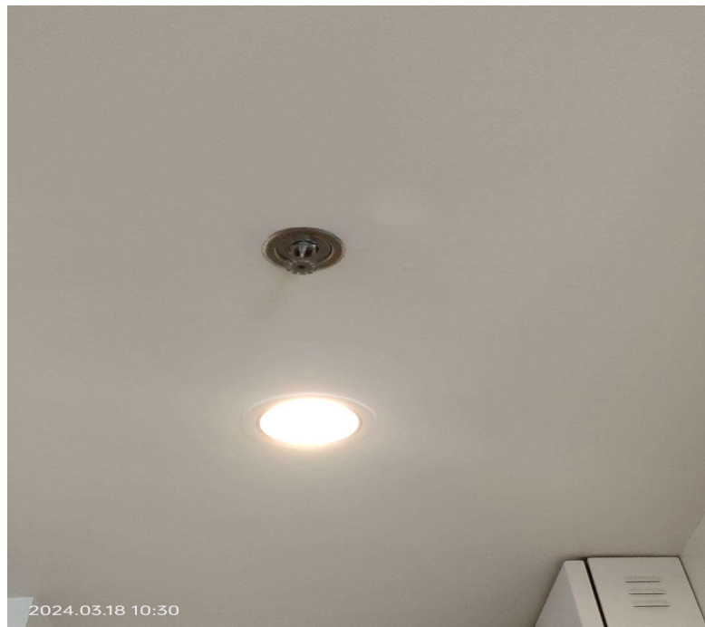
ภาพที่ 12 แสดงระบบดับเพลิงอัตโนมัติ
