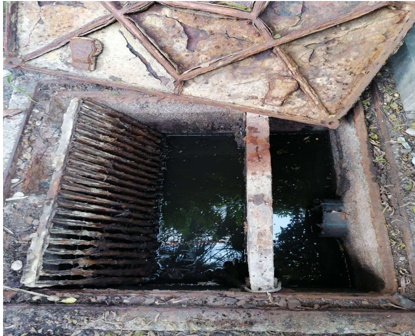
ภาพที่ 21 แสดงบ่อบำบัดน้ำเสียที่ติดตั้งตะแกรงดักมูลฝอย
