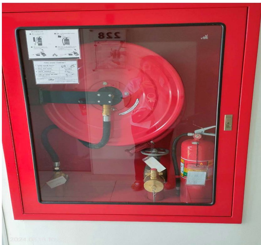
ภาพที่ 6 แสดงถังดับเพลิง และป้ายแสดงจุดติดตั้ง
