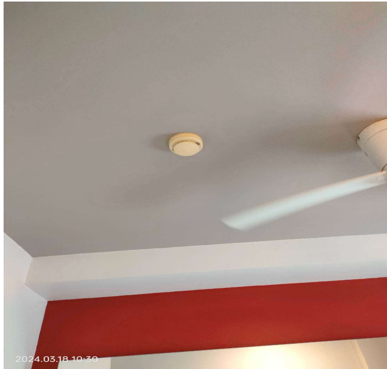
ภาพที่ 11 แสดง เครื่องตรวจจับความร้อน ภายในห้องพักของโครงการ
