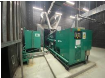
รูปที่ ฎ7.34 ระบบไฟฟ้าสำรอง
