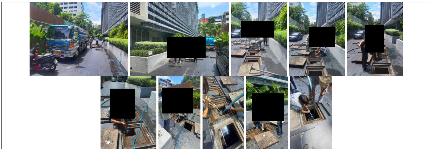
รูปที่ ๗7.10 การสูบลำโพงไฟจากบ่อพักไฟ และสูบลำโพงไฟจากบ่อพักไฟ
