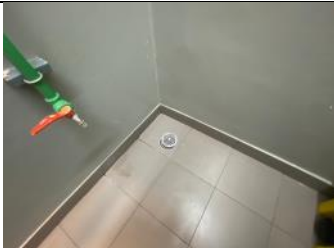
รูปที่ ฆ7.67 ตะแกรงครอบตามรูท่อระบายน้ำ
