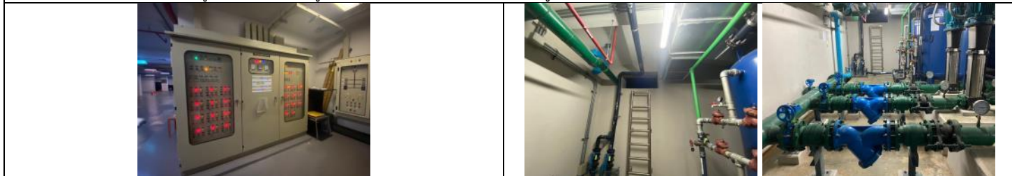
รูปที่ ๗7.11 ตู้ควบคุมระบบบำบัดน้ำเสีย และมิเตอร์ไฟฟ้าของระบบ บำบัดน้ำเสีย
