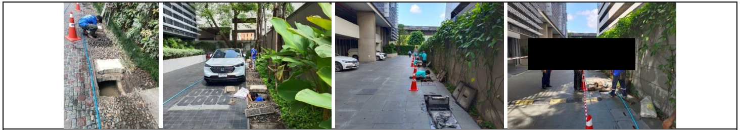
รูปที่ ผ7.24 เจ้าหน้าที่ขุดลอกการสะสมของตะกอนดิน
