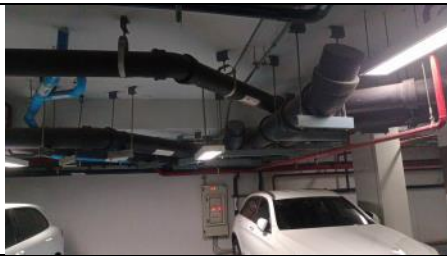
รูปที่ ฎ7.30 ท่อรวบรวมน้ำจากการล้างห้องพักรถปล่อย
