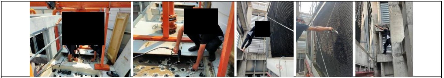
รูปที่ ผ7.59 เจ้าหน้าที่เข้าทำความสะอาดและกำจัดตะกอนในหอผึ่งเย็น
