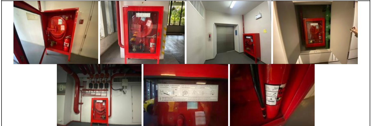
รูปที่ ผ7.43 ตู้เก็บสายฉีดน้ำดับเพลิงพร้อมอุปกรณ์ (FHC) และวิธีการใช้อุปกรณ์
