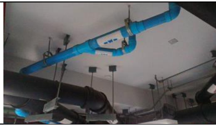
รูปที่ ฎ7.30 ท่อรวบรวมน้ำจากการล้างห้องพักรถปล่อย
