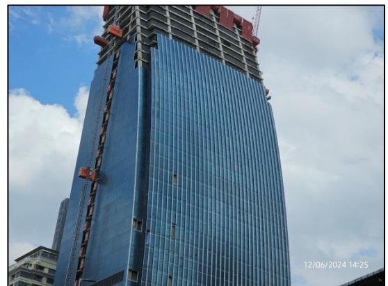
รูปที่ 17 ติดตั้งกระจกตลอดความสูงของอาคารทุกด้าน
