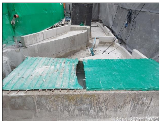
รูปที่ 26 รางระบายน้ำ บริเวณโดยรอบของพื้นที่โครงการ เพื่อรวบรวมน้ำเข้าสู่บ่อพักน้ำ
