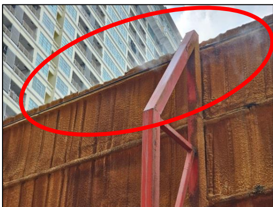
รูปที่ 15 ติดตั้งระบบพ่นละอองสเปรย์น้ำ บริเวณรั้ว Metal Sheet รอบโครงการ
