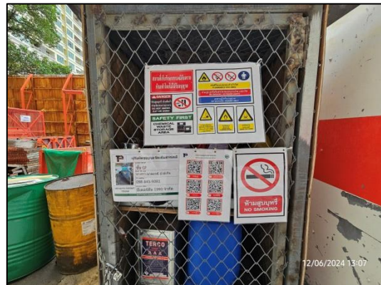
รูปที่ 31 พื้นที่วางวัตถุกั้นไฟ หรือสารเคมีให้เป็นสัดส่วนพร้อมติดป้ายเตือนอย่างชัดเจน
