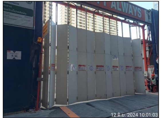
รูปที่ 16 ประตูทางเข้า - ออกพื้นที่ก่อสร้าง เป็นประตูเลื่อน และปิดทึบตลอดเวลา
